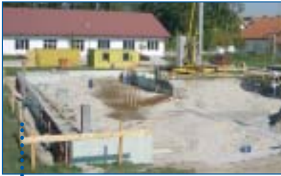
• Die Grundmauern werden gezogen
