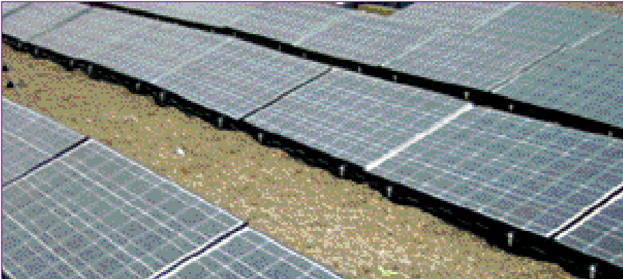
Modernste Technik auf dem Dach der Pfarrkirche: Die umweltfreundliche Photovoltaikanlage
