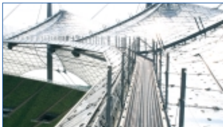
Ein Highlight am 30. August 2006: Die Zeltdachtour über das Olympiastadion
