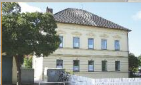
Sanierung der Villa Ismaier Seite 6
