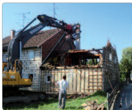
Abriss Dorfstraße 2 und 4
