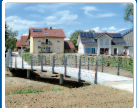
Neue Brücke zum Bahnhof
