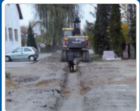
Sanierung Hummler Straße
