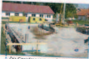
Die Grundmauern werden gegossen.
