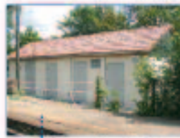
Das neue Stellwerkgebäude am Langenbacher Bahnhof
