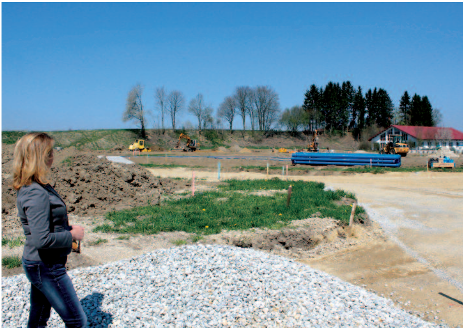
Die Kanalbauarbeiten sind schon bald abgeschlossen
