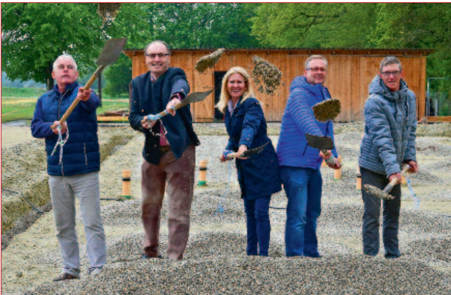
Kräftig schaufeln hieß es beim 1. Spatenstich. Lambert Summer, Christian Huber, Bürgermeisterin Susanne Hoyer, Architekt Michael Wacker und Emanuel Keilhacker (v.l.). Foto: R. Lex
