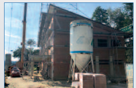
Richtfest beim SV Langenbach
