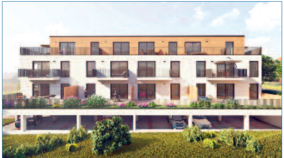
Das Staffelgeschoss (oben) wird in Holzbauweise errichtet, das Dach ist begrünt und trägt eine Photovoltaikanlage.
