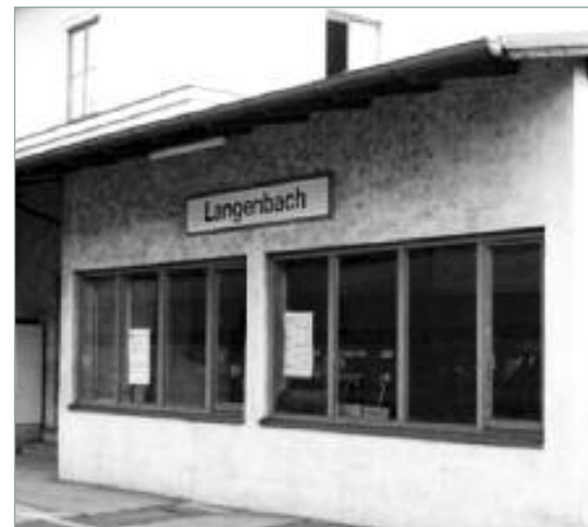
Der heute noch vorhandene (aber leere) Anbau für das Stellwerk des Fahrdienstleiters
