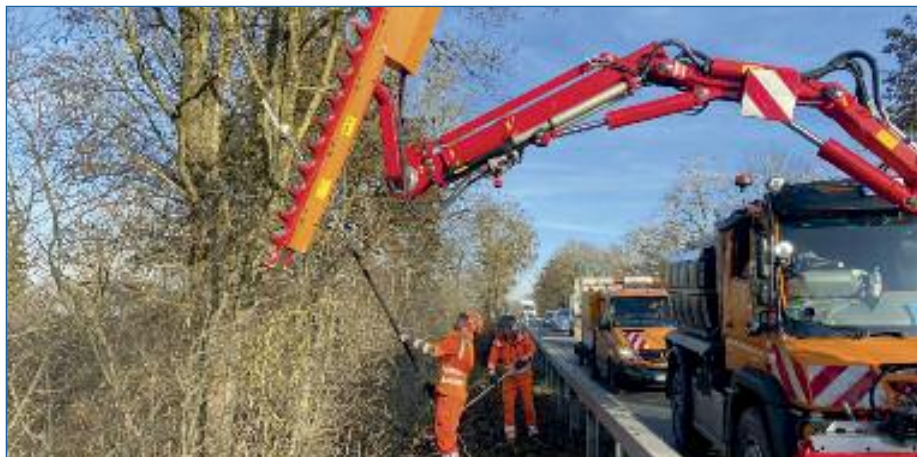
Sträucher und Bäume am Straßenrand müssen regelmäßig zurückgeschnitten werden. Dass ein Baum aus Gründen der Verkehrssicherheit gefällt werden muss, kommt mitunter auch vor. Das Staatliche Bauamt versucht aber, Bäume so lange wie möglich zu erhalten.
