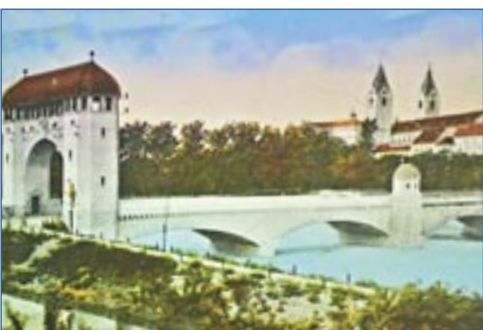
Nur noch alte Freisinger kennen die Isarbrücke von Osten her und das mächtige Tor so wie auf diesem Bild.
