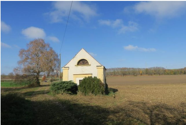
Kapelle, denkmalgeschützt, Blick nach Norden
