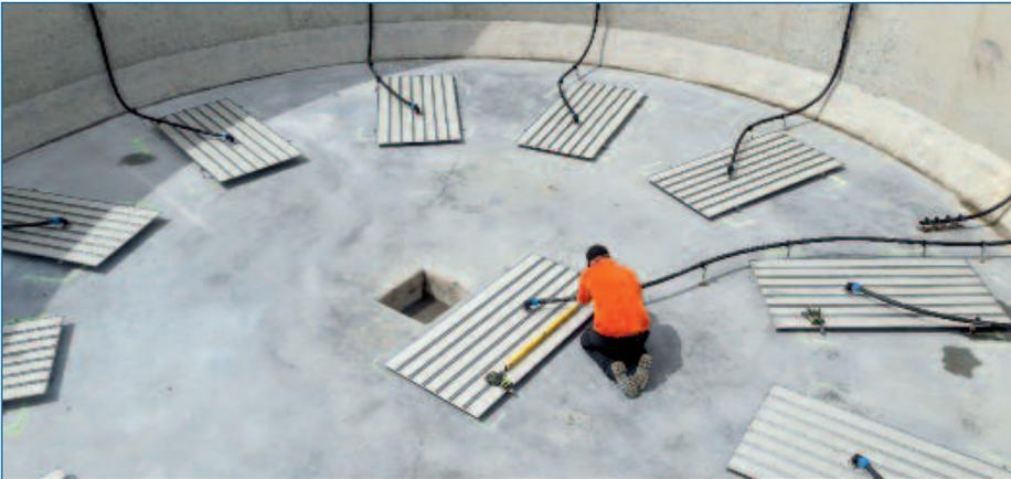
Das alte Nachklärbecken wurde inzwischen zum Belebungsbecken II mit der neuen Belüftungstechnik umgerüstet. Die Arbeiten am Belebungsbecken I sind bereits abgeschlossen.
