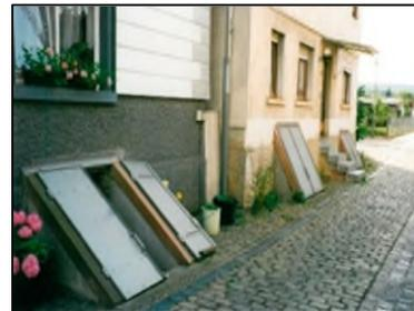
links: Abdichtung eines Kellerabgangs, rechts: Abdichtung von Fenster
