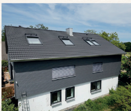
energetische Sanierungen für Dach und Wand, Fassadenverkleidungen
